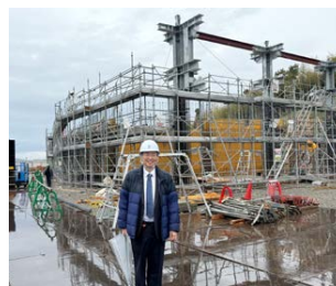
▲新消防庁舎建設現場視察
