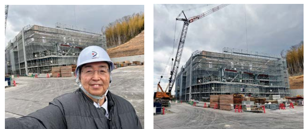
▲相楽中部消防組合本部 新築工事 現場視察
