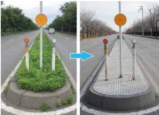
張りコンクリート工法
